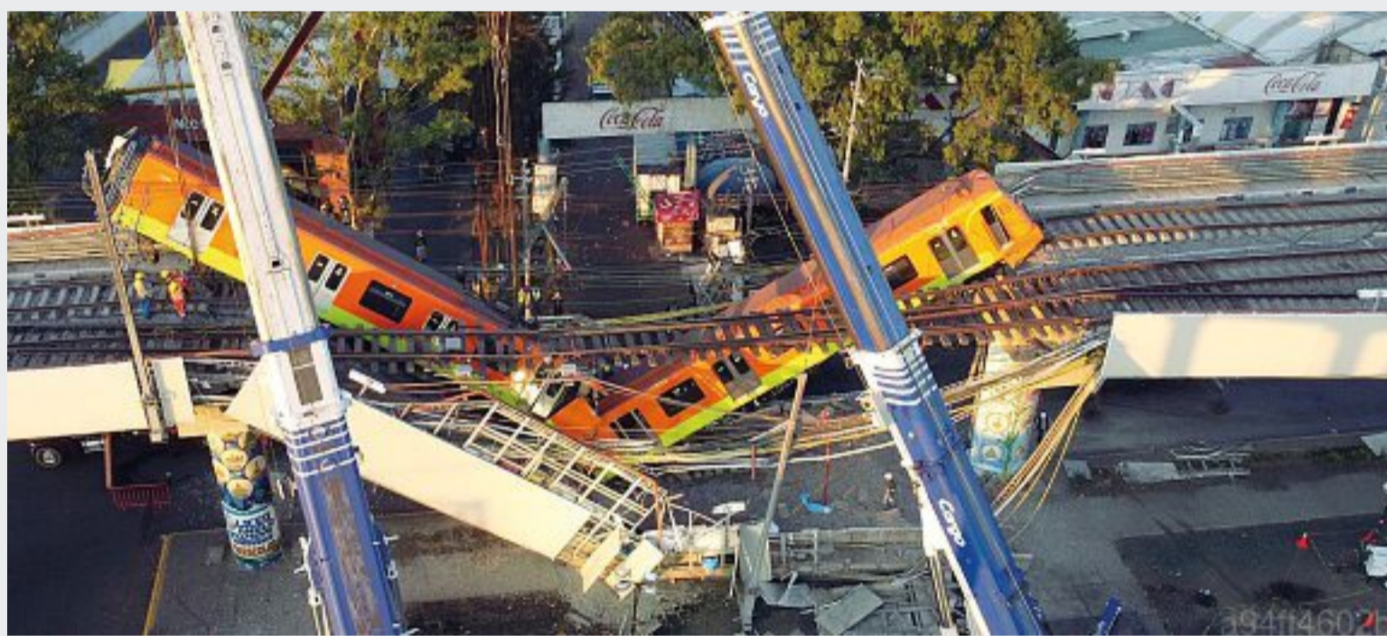
I danni Le immagini riprese da un drone mostrano due carrozze del treno della metropolitana di Città del Messico nel punto in cui è crollato il ponte (Gutierrez/Epa)
